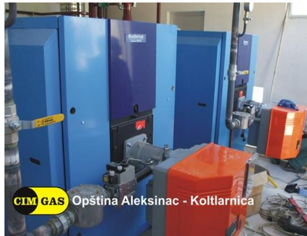
CIM GAS Dom kulture - Aleksinac Kaskadno povezani Luna HT kotlovi od 100 kW
